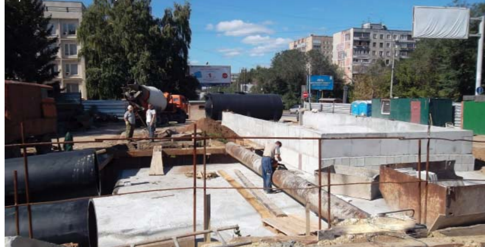
Строительство станции «Алабинская»
