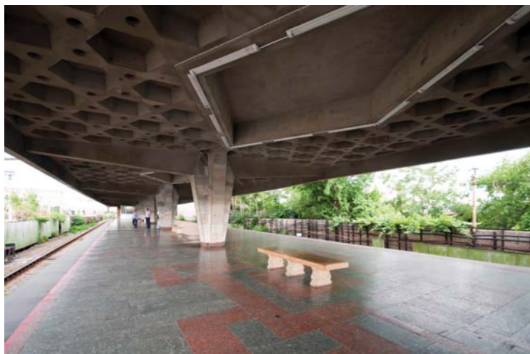
Станция «Сасунци Давид»
