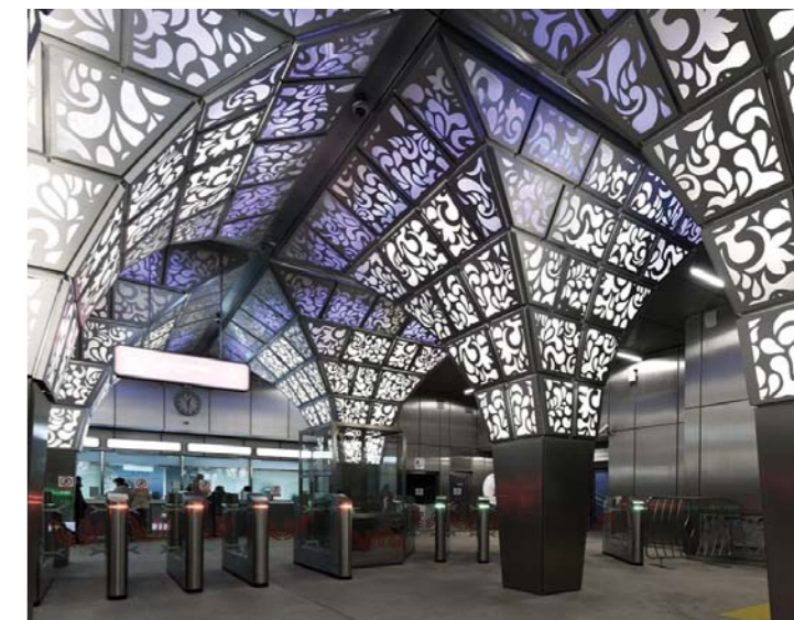
Подземный вестибюль станции метро «Новопеределкино», Москва
