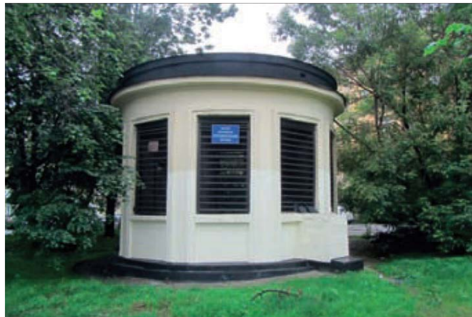
Рис. 8. Вентиляционный киоск ВШ
