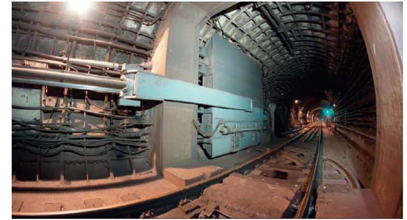
Рис. 10. Тоннель с гермозатвором
